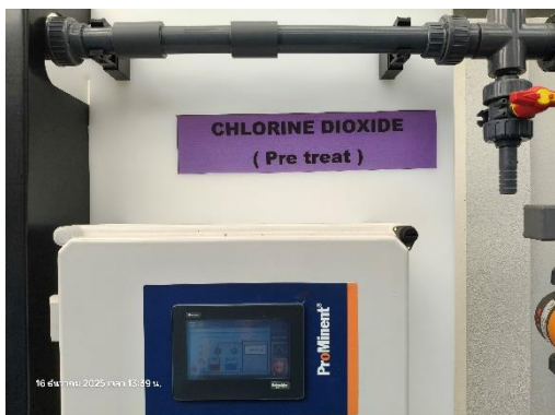
เครื่องเติมคลอรีนแบบอัตโนมัติ
