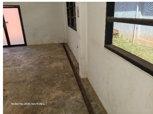
วางระบายน้ำไปยังระบบบำบัดน้ำเสีย
