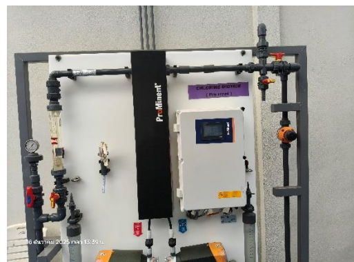
เครื่องเติมคลอรีนแบบอัตโนมัติ
