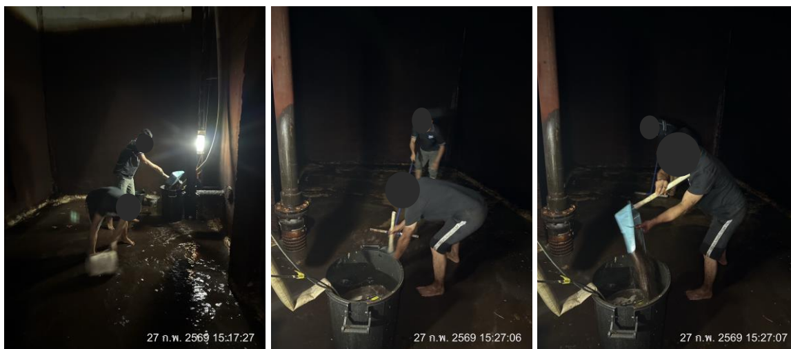
ภาพที่ 2-25 การล้างถังเก็บน้ำใต้ดิน และถังสูง
